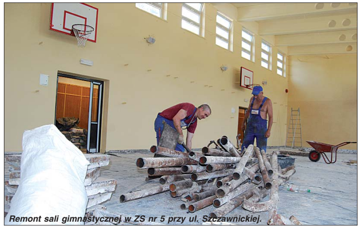
Remont sali gimnastycznej w ZS nr 5 przy ul. Szczawnickiej.
