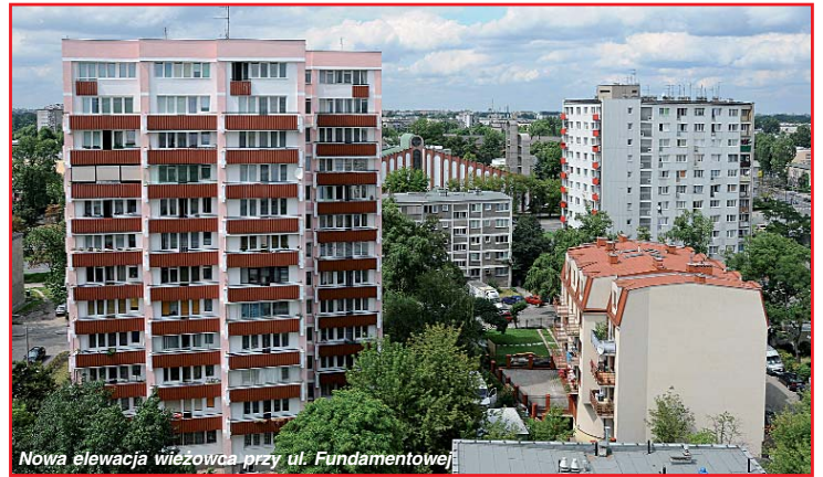
Nowa elewacja wieżowca przy ul. Fundamentowej
