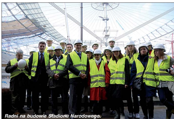
Radni na budowie Stadionu Narodowego.
