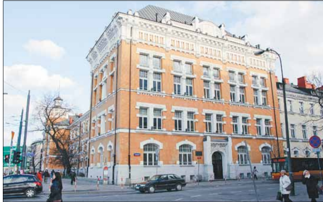
Zabytkowy budynek Liceum Ogólnokształcącego im. Władysława IV po renowacji.
