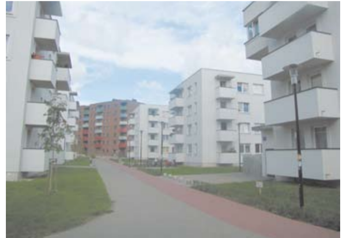
Nowe budynki komunalne przy ul. Jagiellońskiej 47
