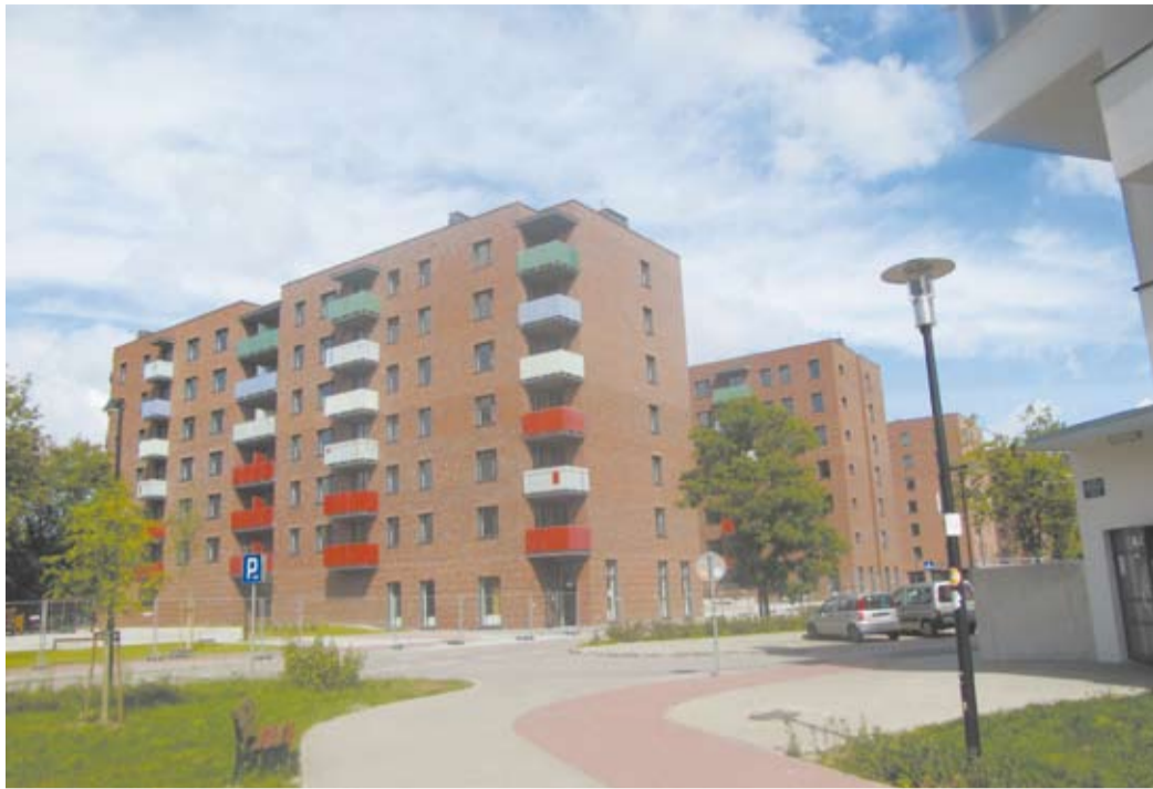
Nowe budynki komunalne przy ul. Jagiellońskiej 47
