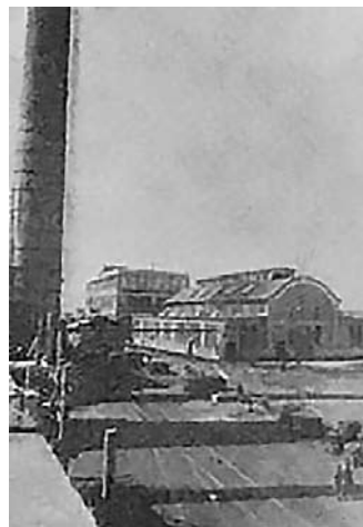
Pocisk Praga. Budynki żelbetowe z kominem żelbetowym 50 m wysokości wykonane od 1920 r. do 1924 r.
