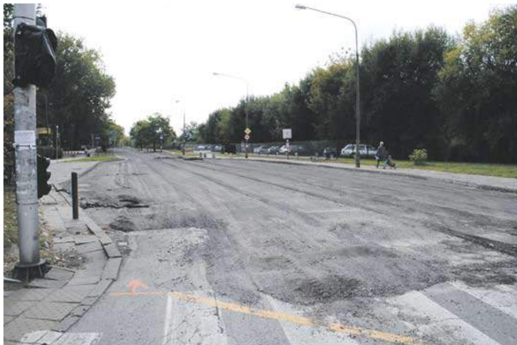
Piątek, 30.09.2016, godz. 11.35 – na placu budowy pustki.
