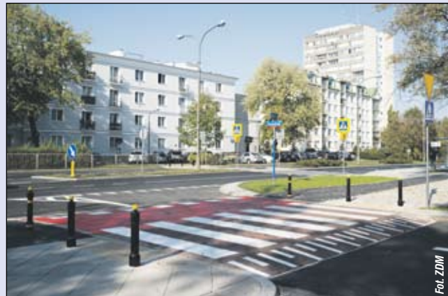
Przykładowe tzw. wyniesione przejście dla pieszych przy ul. Krasińskiego.
