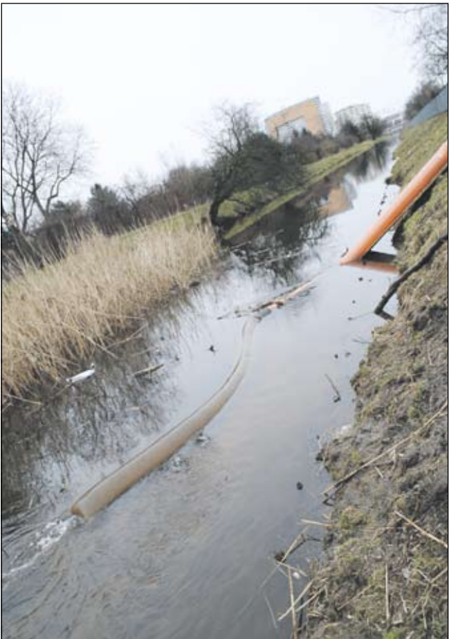
Od tygodni trwa zrzut wody do Kanałku Wystawowego.
