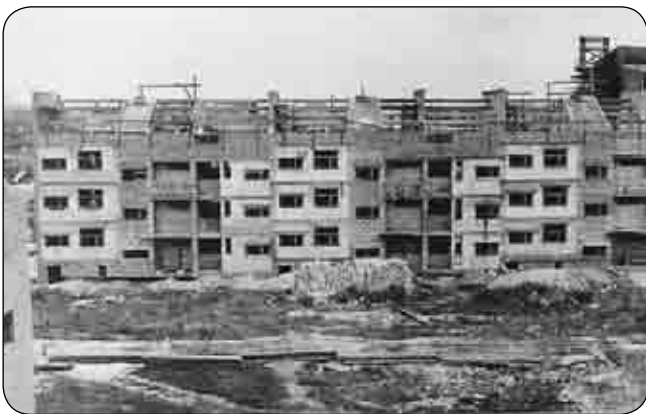
Niewysoki budynek w trakcie budowy w 1957 roku...
