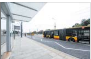
Platforma dla wsiadających na przystanku Stare Miasto Fot. R. Motyl
