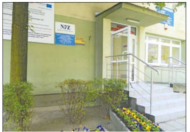
Wyremontowane wejście do poradni stomatologicznej.
