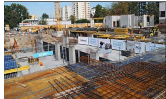
Inwestycja wyrasta już z poziomu „0”.
