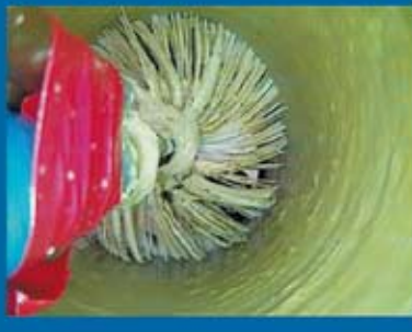
NAKŁADANIE POLIMERU WEWNĄTRZ KANALIZACJI
