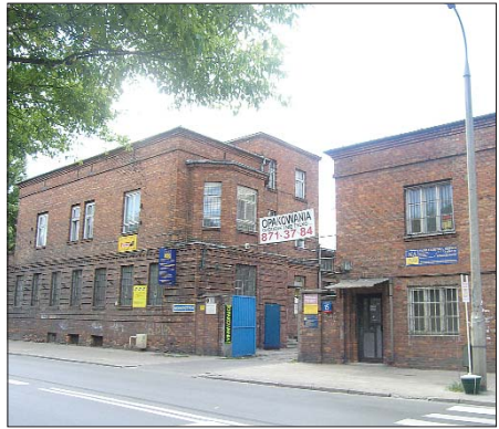
Stan przed rozbiórką...
