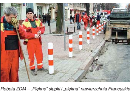
Robota ZDM – „Piękne” słupki i „piękna” nawierzchnia Francuskiej.
