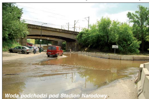
Woda podchodzi pod Stadion Narodowy.
