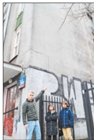
– W przedwojennych planach tu miała być winda – o instalację dźwigu przy Waszyngtona 14A stara się m.in. rodzina państwa Gniewaszewskich.
