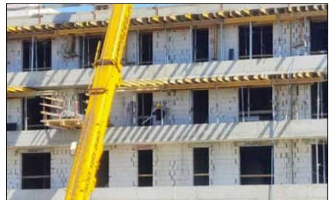
Trwa budowa apartamentowca WESTIN HOUSE Resort Kołobrzeg.
