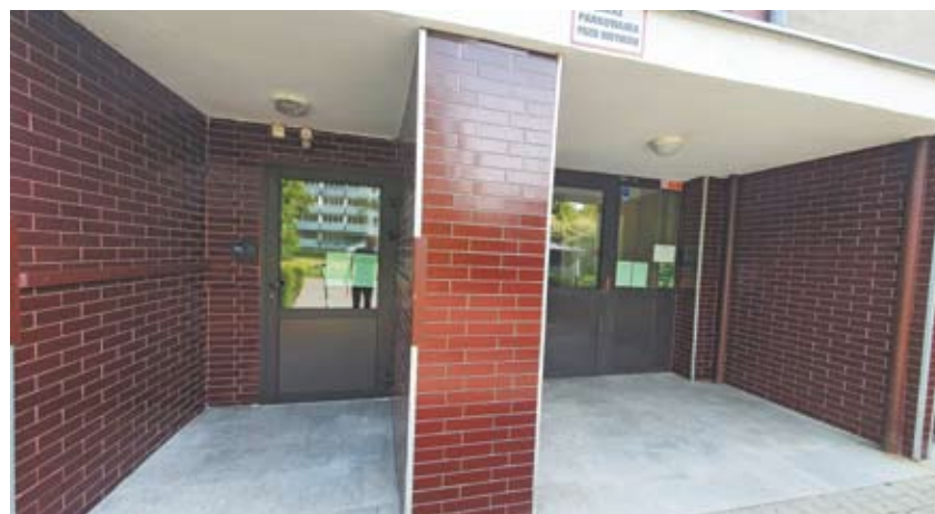
3 Wejście do windy i budynku z poziomu przyziemia – Adm. Os. Domaniewska 2.
