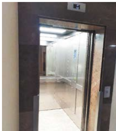
1 Wymiana dźwigu w systemie powiększenia kabiny i poszerzeniem drzwi.
