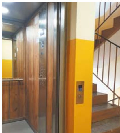
1 Wymiana dźwigu w systemie powiększenia kabiny i poszerzeniem drzwi.
